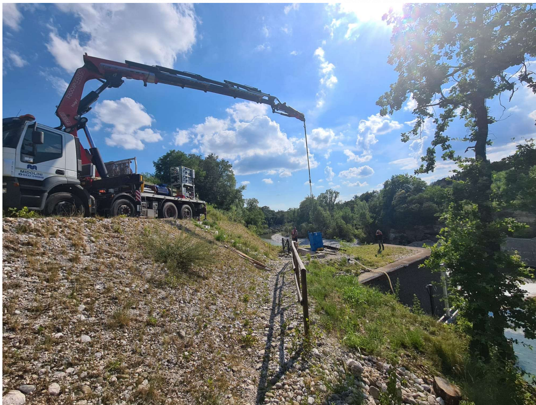
Figura 29: Revisione motori e riduttori e successivo rimontaggio presso centrale idroelettrica.
