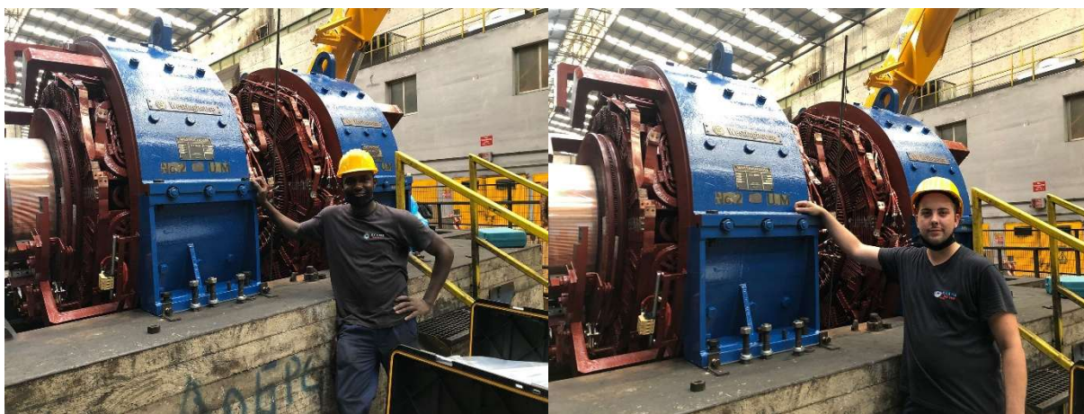
Figura 27 e 28: Service on site, revisione + montaggio.
